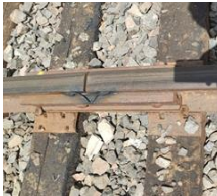
Unión con planchuelas para vía clásica
