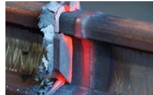
Unión con soldadura alumino-térmica para vía elástica
