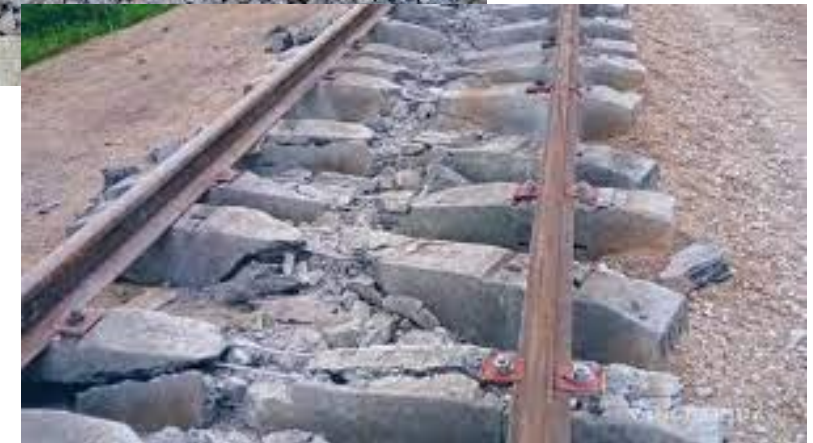
Vía del istmo de Tehuantepec (febrero, 2022)
