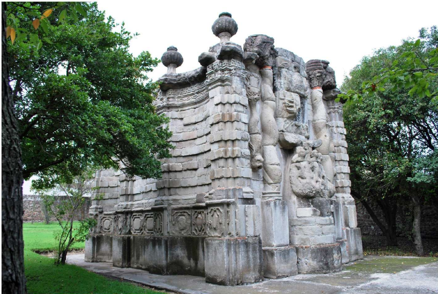
Fuente de Salto del Agua (Tepotzotlán)
