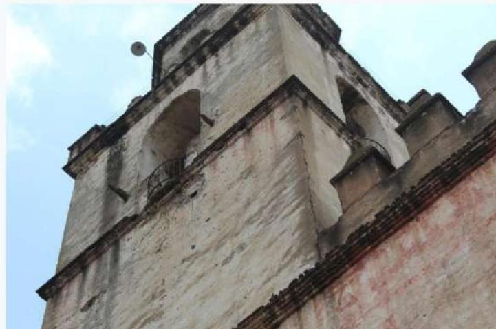
Figura 8. Cuerpos superiores de la torre campanario, con huellas de impactos de bala.
