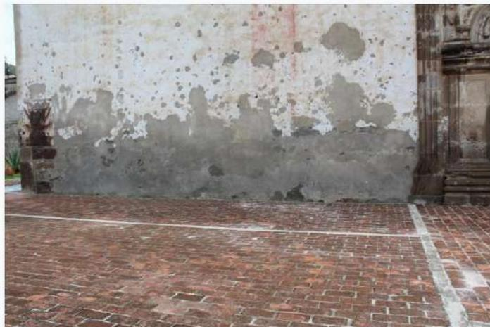
Figura 11. Los resanes en la sustitución de los aplanados en la parte baja de los muros, probablemente no se utilizan materiales compatibles a los originales.
