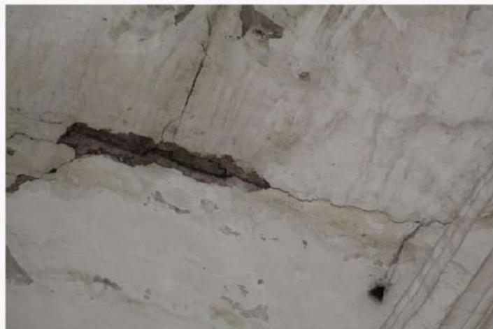
Figura 10. Agrietamientos en el intradós de la bóveda, se observa que en acciones de rehabilitación anteriores, la reparación no ha sido suficiente para corregir el daño.
