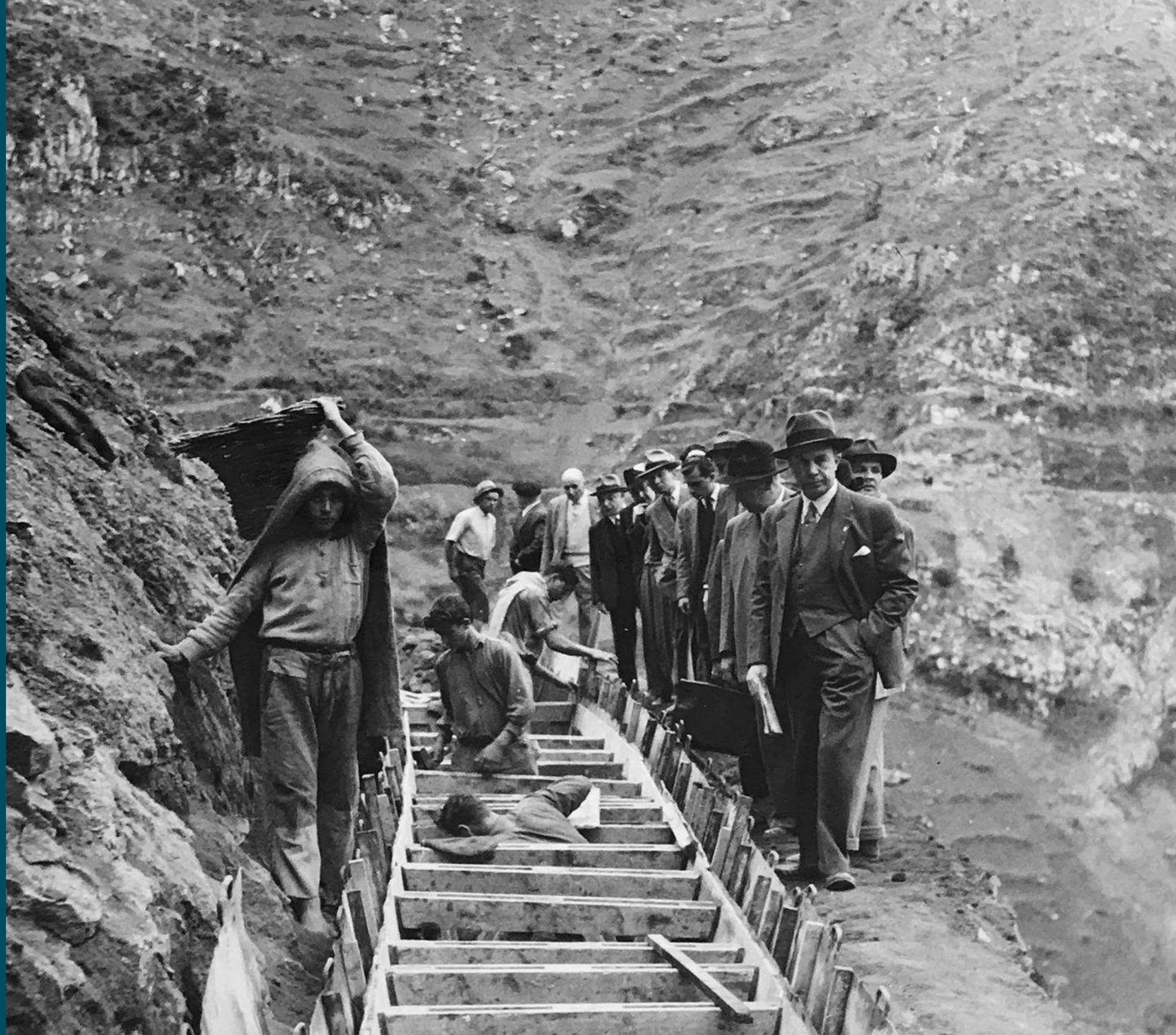
Trabalhos na construção da Levada do Norte, anos 50, Foto Perestrellos
